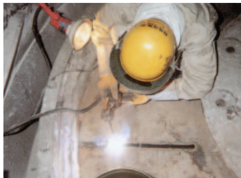
縦ミル現地補修
