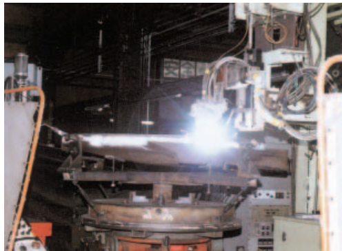
弁体シート面・プラズマ粉体肉盛溶接
