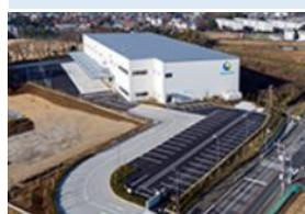
トラックバース20台分、トラック待機場場57台分設置により、特定時間帯に集中する入出荷に対応
