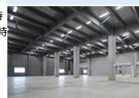
1階部分につき、有効天井高7.5mとすることで、テナント企業が要望するラックの4段積みオペレーションに対応
