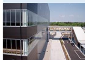
従業員が駐車場から直接エスカレーターで2階にアプローチして入館する特徴的な仕様を採用し、歩行者動線とトラック動線を分離することで安全性を確保
