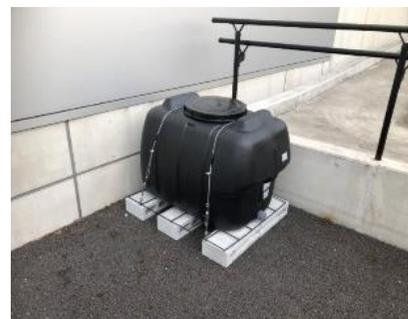
雨水貯水タンクを設置し、植栽水やりや外構の水撒きなどへ雨水を再利用
