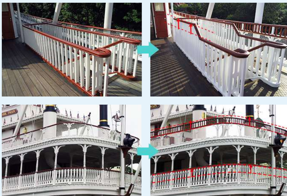
蒸気船マークトウェイン号の柵の高さを変更
