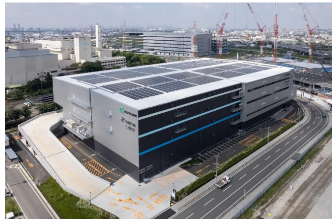
GLP ALFALINK 茨木 2 ソーラー発電所
