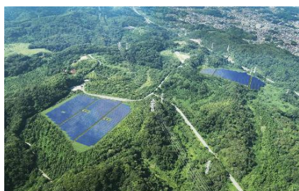
西武武山ソーラーパワーステーション
