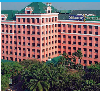
民間総合病院グループのシロアム病院（インドネシア）
