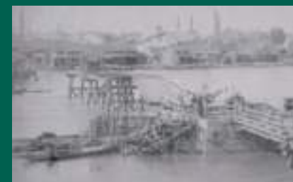
明治18年の大洪水で流された旧淀川の天満橋 （画像提供：国土交通省淀川河川事務所）
